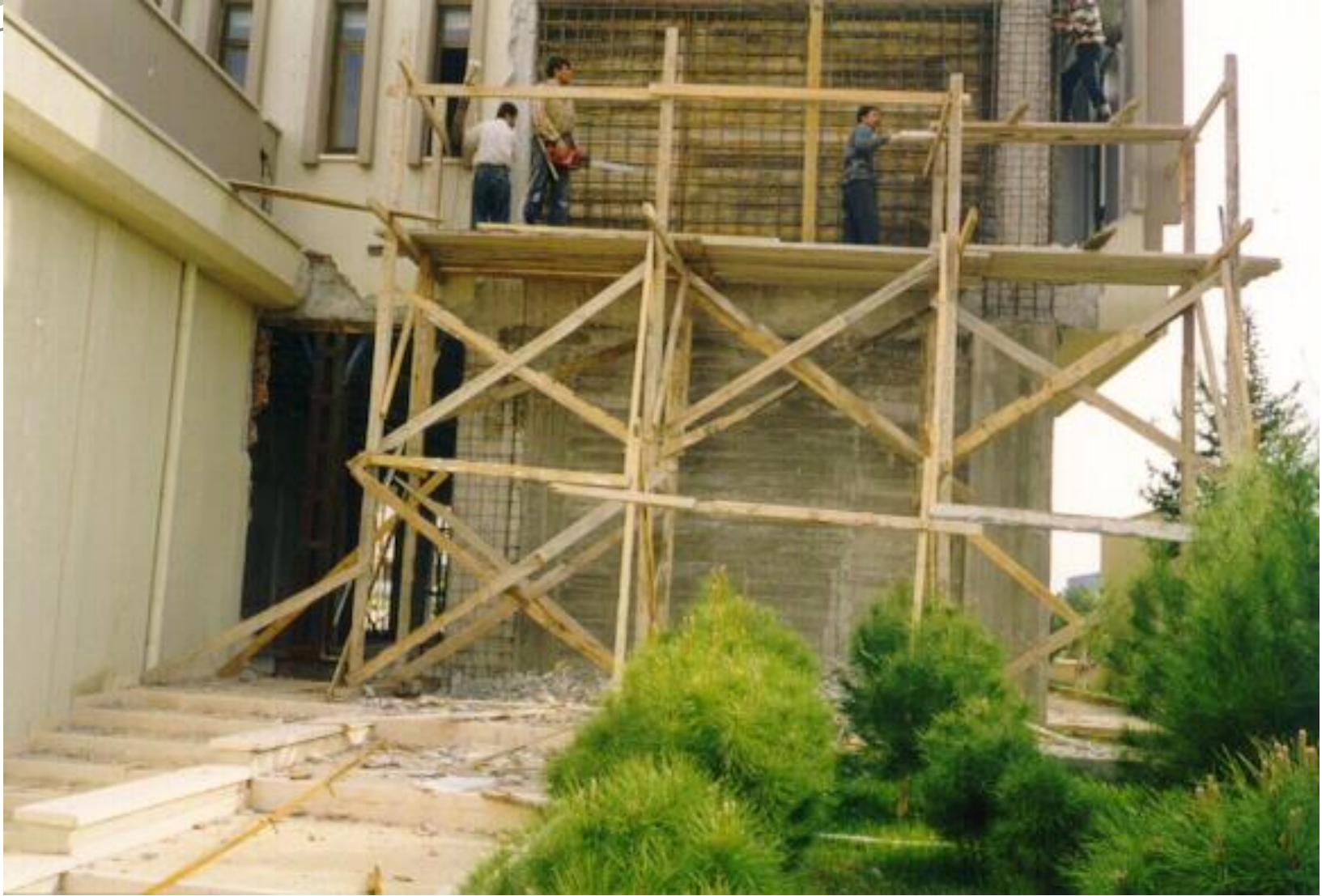
2 NOLU PERDENİN İNŞAATI
