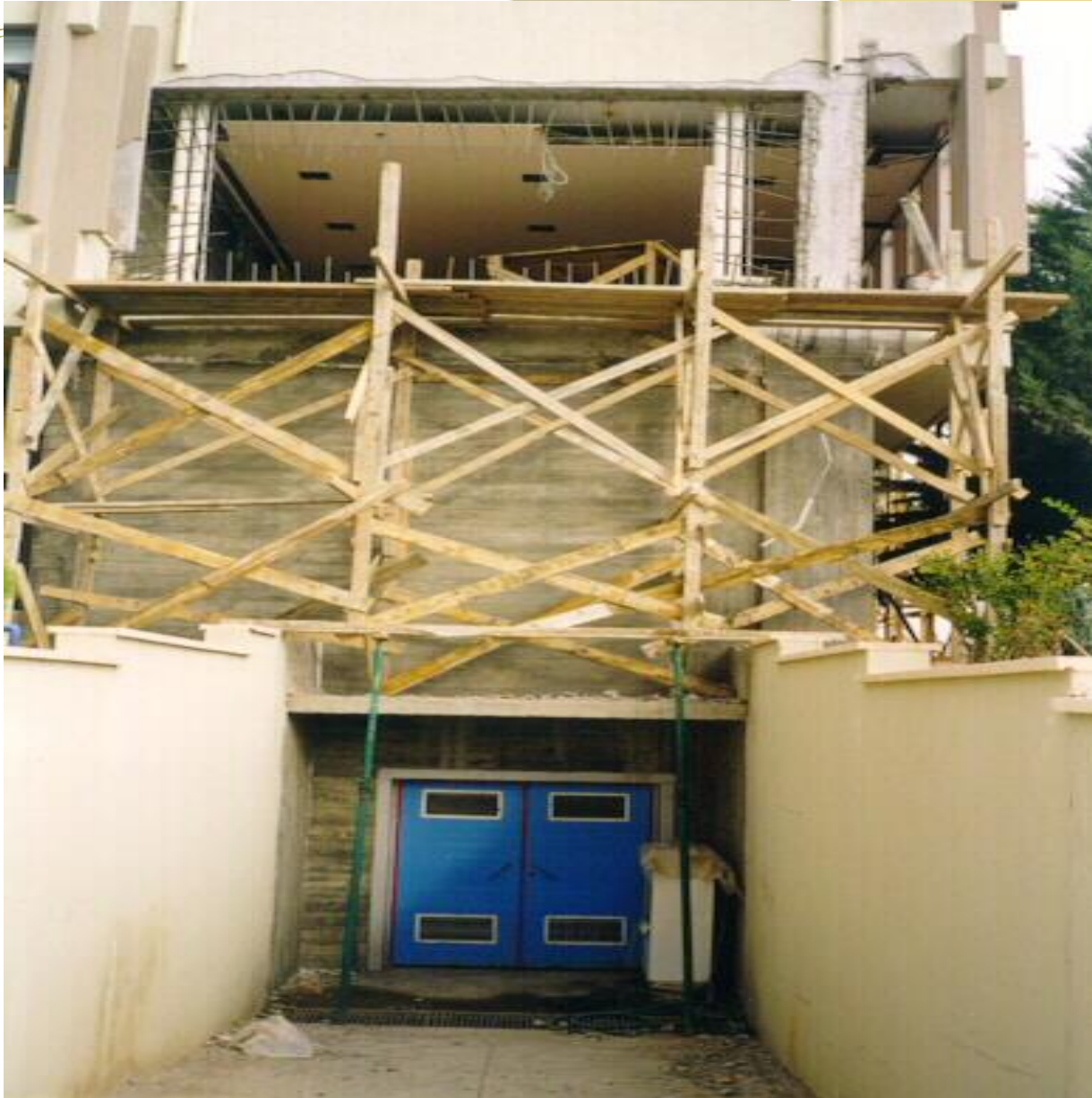
4 NOLU PERDENİN İNŞAATI
